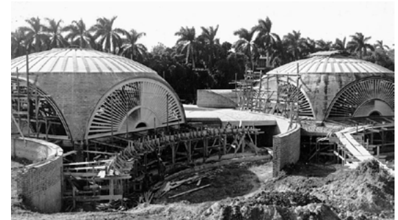
Fig. 21 Imagen de la construcción. Escuela de Ballet, Vittorio Garatti
