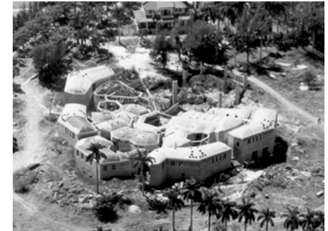
Fig. 16 Escuela de Arte Dramático en construcción, Roberto Gottardi
