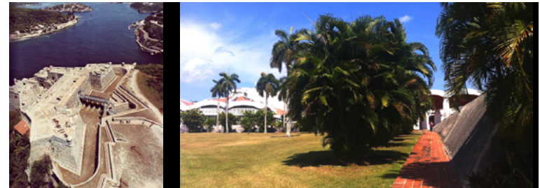
Fig. 12. Castillo de San Pedro de la Roca, Isla de Cuba. Muros laterales de la Escuela de Danza Moderna.
