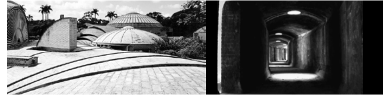
Fig. 29 Escuela de Ballet, cubiertas practicables y corredores interiores, Vittorio Garatti
