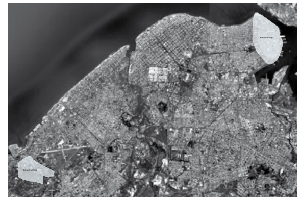
Fig. 9 Foto aérea de La Habana y ubicación del Country Club Park.
