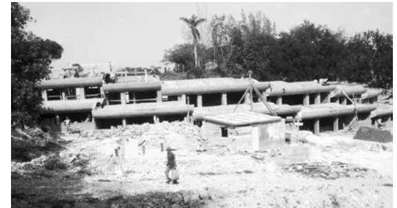
Fig. 22 Imagen de la construcción. Escuela de Música, Vittorio Garatti
