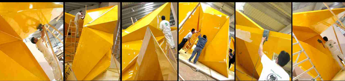
Premontaje en nave industrial
