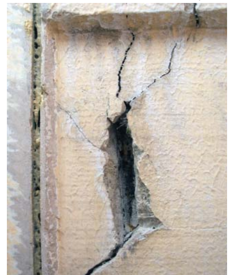
Junta entre paneles de GRC con deterioro del sellado de la junta, y punto de rotura del panel debido a oxidación del anclaje metálico del panel.
