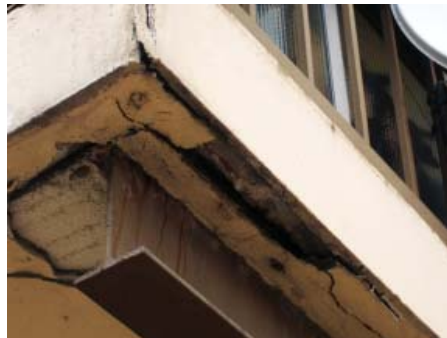
Izquierda y arriba. Grietas y desprendimiento del revestimiento en los cantos de los forjados, provocado por la oxidación de la estructura metálica.
