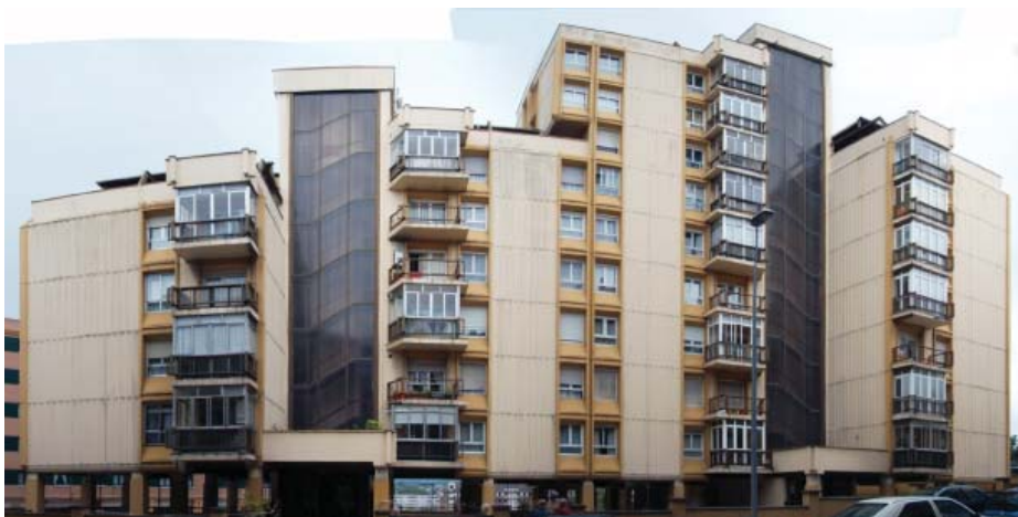
Imagen de la esquina norte del edificio previa a la intervención. Detenido del cerramiento de cajas de escalera, formado por paneles de policarbonato.
