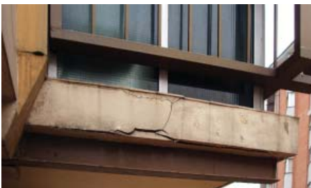
Izquierda y arriba. Grietas y desprendimiento del revestimiento en los cantos de los forjados, provocado por la oxidación de la estructura metálica.
