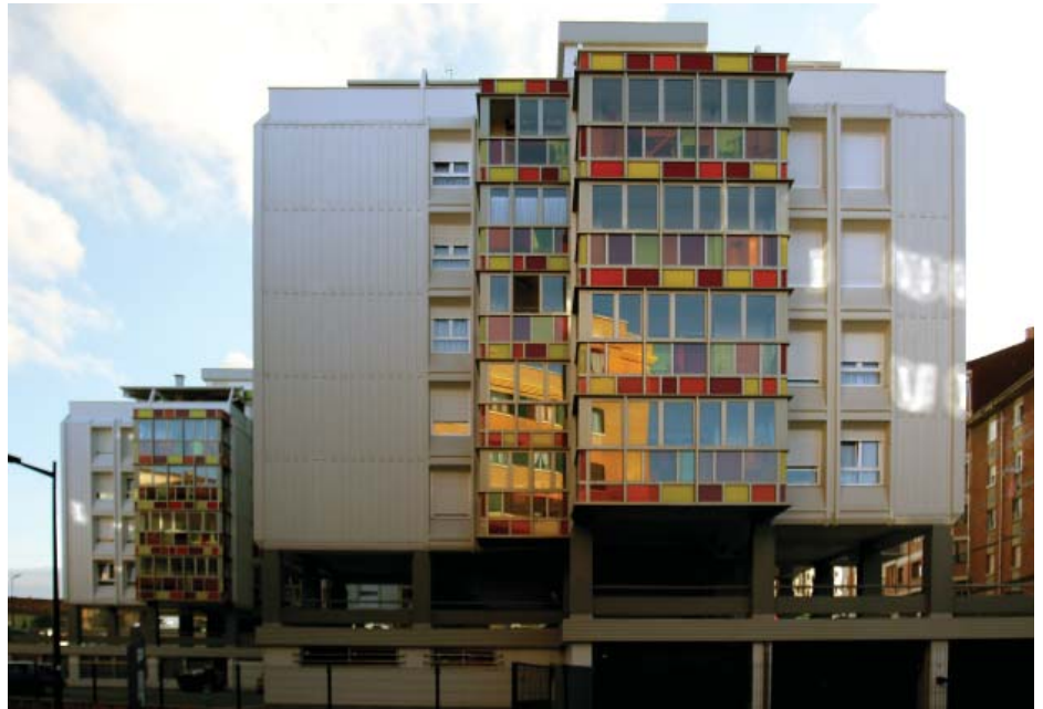
Esquina noreste del edificio posterior a la intervención.
