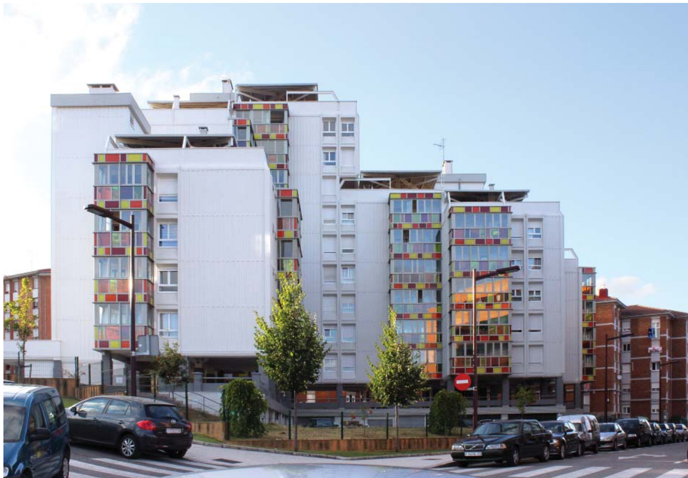
Arriba. Fachada sur del edificio tras la intervención. Derecha. Fotografía detalle de balconadas tras la intervención
