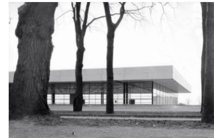
Pabellón polideportivo en Landskrona proyectado por Jacobsen (Suecia, 1962-64).
