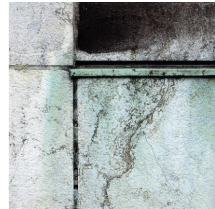
Detalle del revestimiento de mármol empleado por Jacobsen en las fachadas del Ayuntamiento de Aarhus (1937-39).
