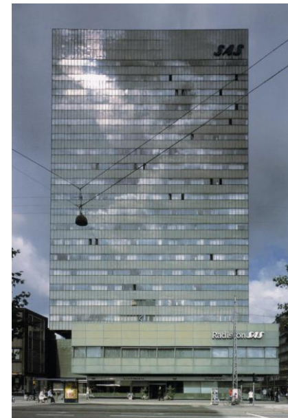
Fachada del edificio SAS-Hotel Royal en Copenhague proyectado por Jacobsen reflejando el cloudscape danés (1955-60).
