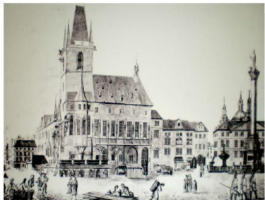
Edificio gótico S.XIV
