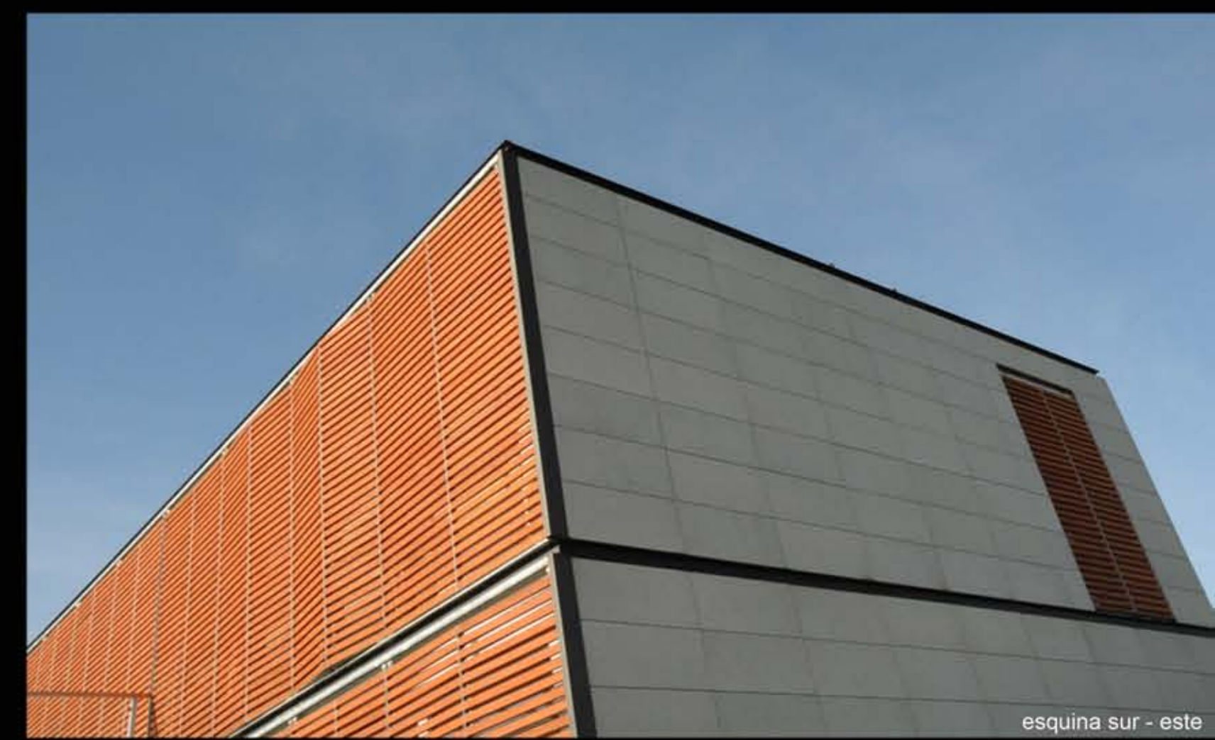
esquina sur - este
