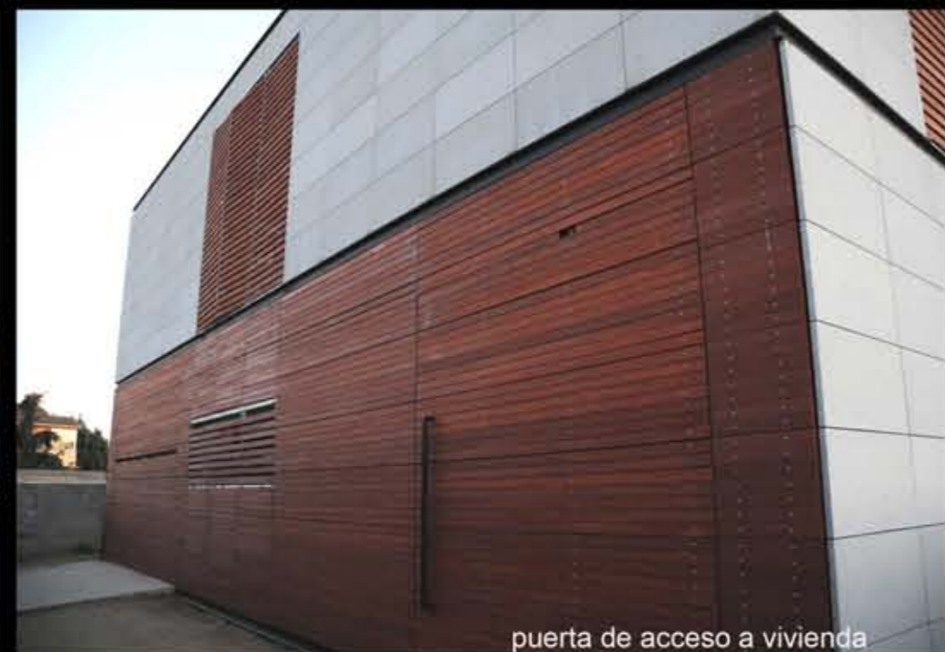
puerta de acceso a vivienda
