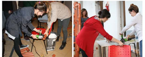
Corte de tubería de PVC y chapa metálica
