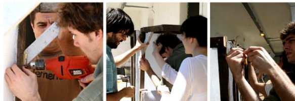
Montaje de bisagras, seguros y cierres
