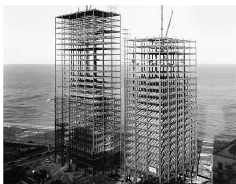
Lake Shore Drive Apartments, Chicago. Mies van der Rohe 1951. Las funciones de estructura y cerramientos también quedan separadas, pero en este caso la pauta de la estructura sirve de referencia tanto a la distribución interior como para la modulación de los sistemas de fachada.
