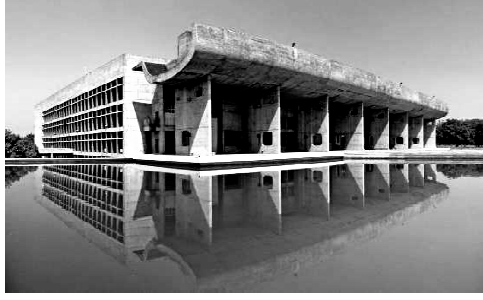
Edificio para la Asamblea de Chandigarh, 1961. Le Corbusier. La plasticidad propia de la estructura de hormigón así como su facilidad para ser “moldeada” se utiliza como uno de los motivos formales característicos de esta etapa de la obra de Le Corbusier.
