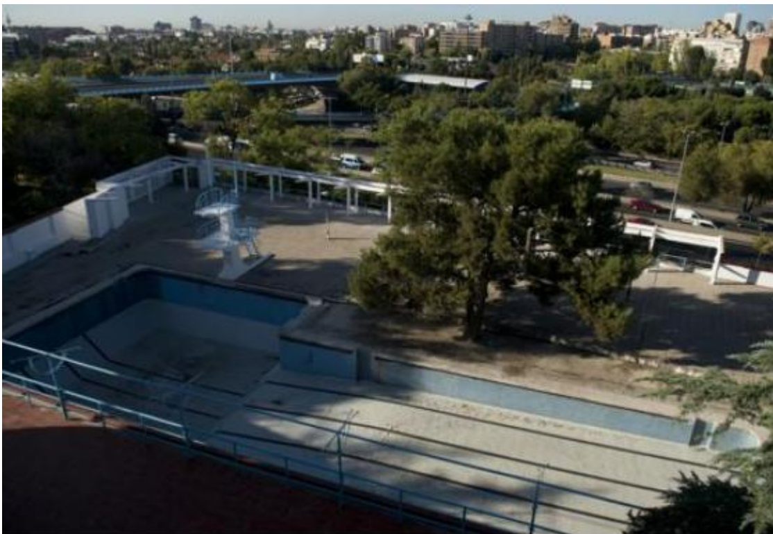
Vistas a la M-30 desde la azotea de la piscina Stella
