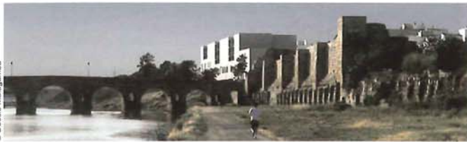
Junta de Extremadura offices, Mérida (1989-95)
