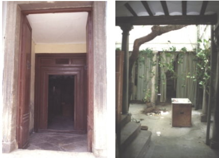
Zaguán de entrada y acceso al patio principal
