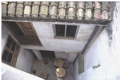
Vista del patio de servicio de la casa patio
