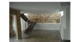
Reforma de vivienda unifamiliar en San Clodio (Ourense) ORENSE. ESPAÑA
